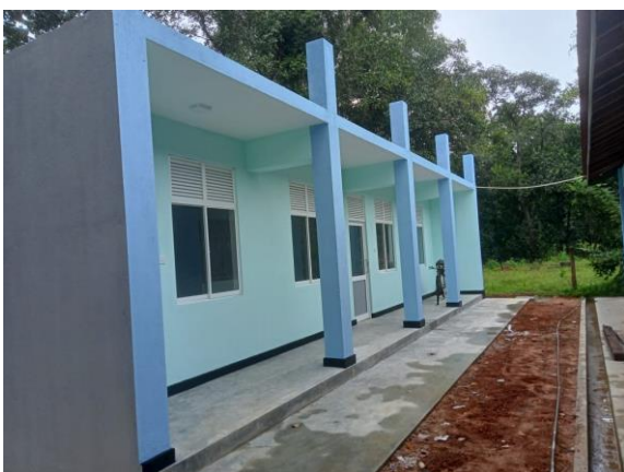
Links: Das 2021 errichtete Gebäude,
